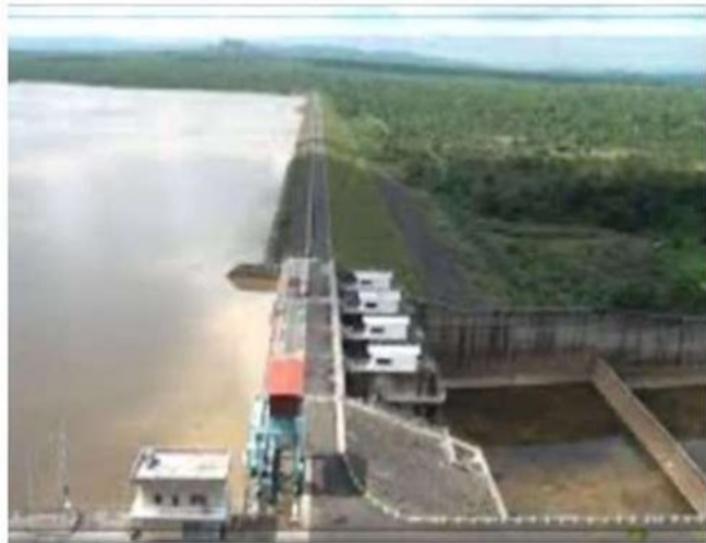
Thủy điện Buon Kuốp
