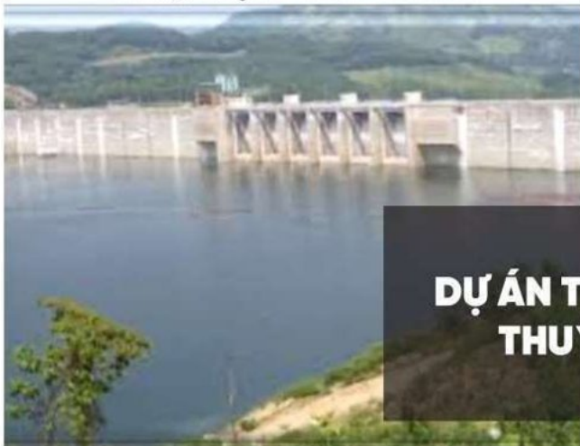
Thủy điện Sông Tranh 2
