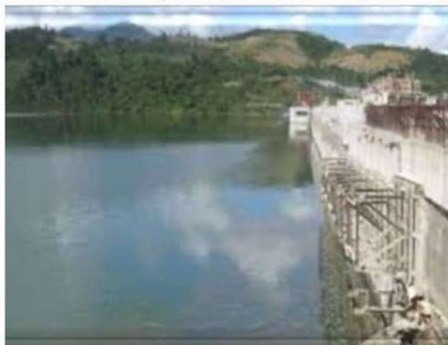
Thủy điện Sông Tranh 3
