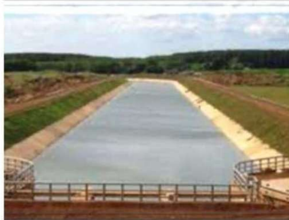
Thủy lợi Phước Hòa GD 2
