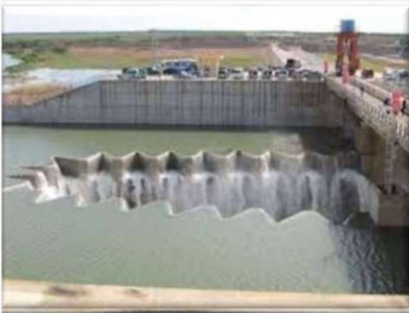
Thủy lợi Phước Hòa GD 1
