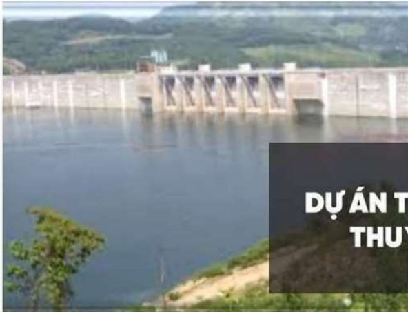
Thủy điện Sông Tranh 2
