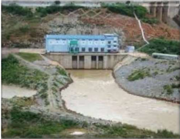
Thủy điện Buôn TuaSa
