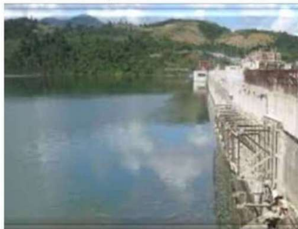
Thủy điện Sông Tranh 3
