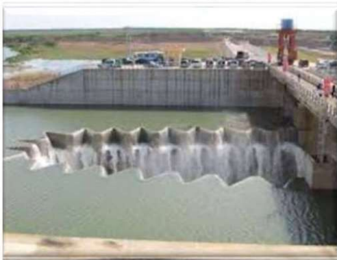
Thủy lợi Phước Hòa GD 1
