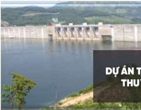
Thủy điện Sông Tranh 2
