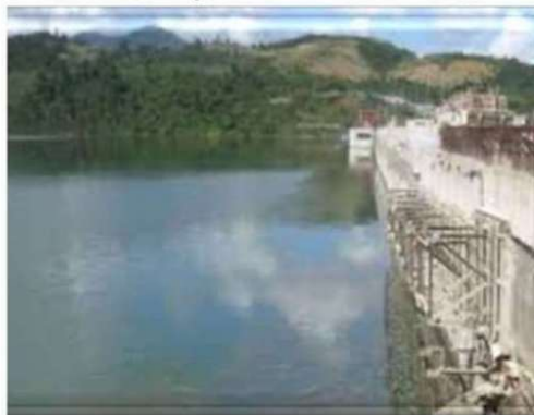
Thủy điện Sông Tranh 3
