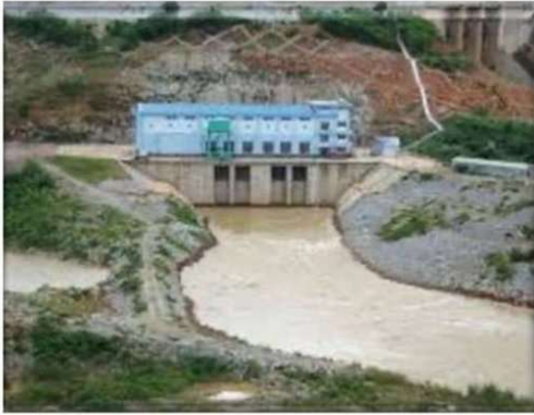
Thủy điện Buon TuaSa
