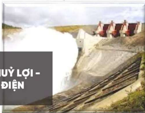
Thủy điện Sook Phu Mieng
