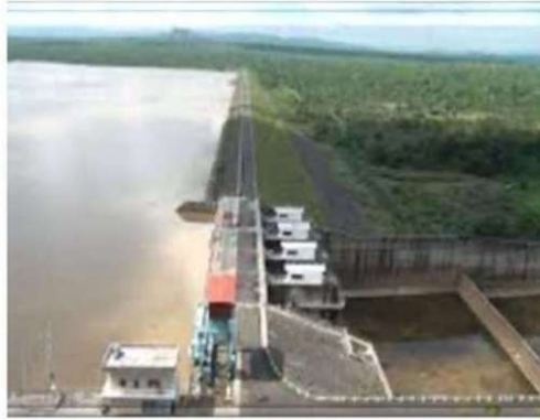
Thủy điện Buon Kuốp
