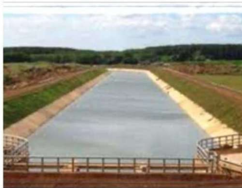
Thủy lợi Phước Hòa GD 2
