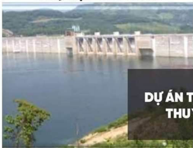
Thủy điện Sông Tranh 2
