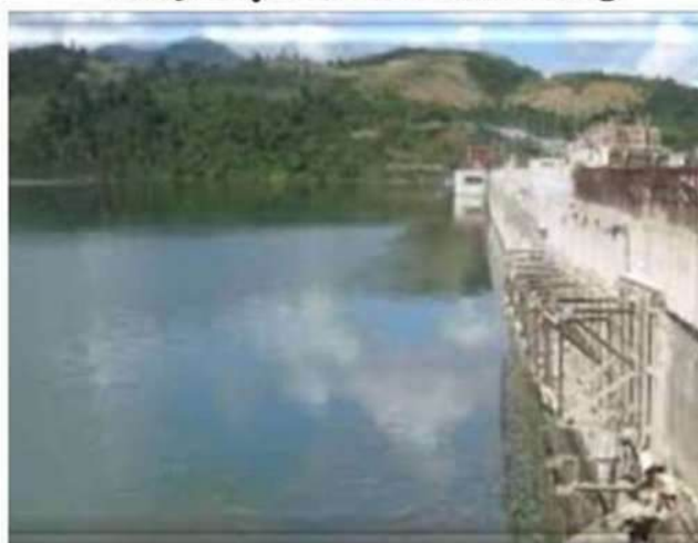
Thủy điện Sông Tranh 3
